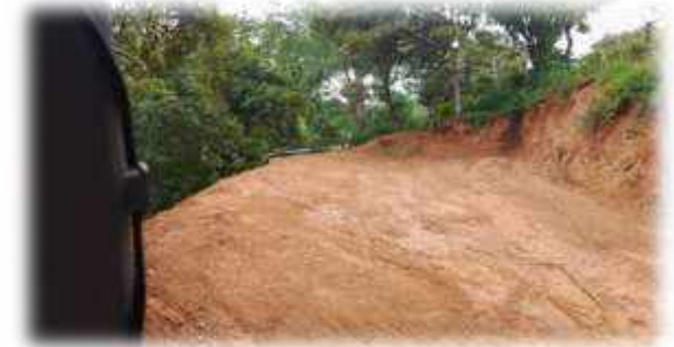
Retroexcavadora L9P02226: La Doradilla, corregimiento de Guadalupe; nivelación de terreno.
