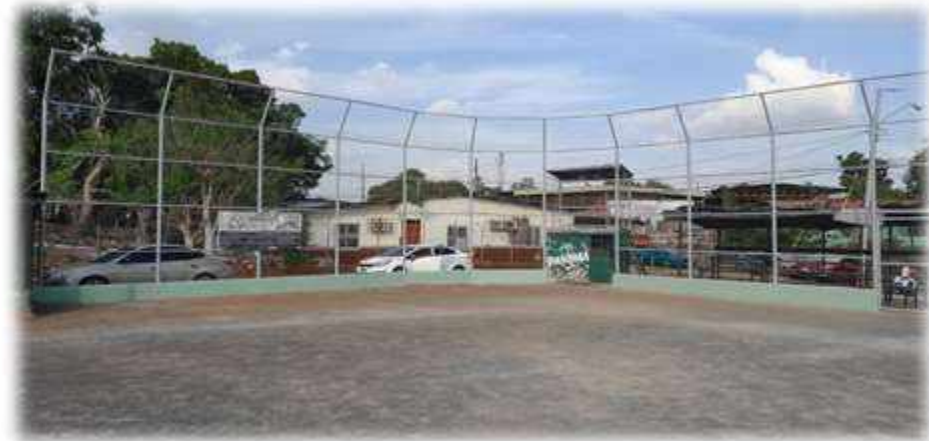
Mejoramiento de la cancha de la Unión.
