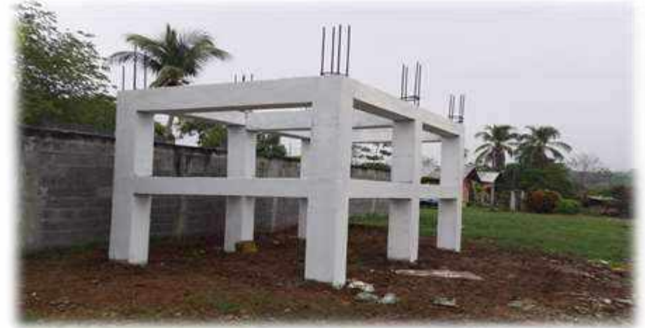
Construcción de base de tanque de agua en El Nazareno.
