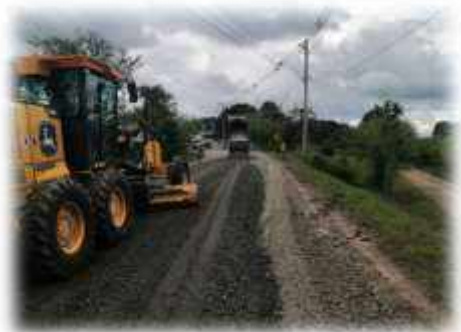
Motoniveladora MC000269: Carretera Las Mendozas; conformación de calzada 250 metros y riego de capa base 100 mts.
