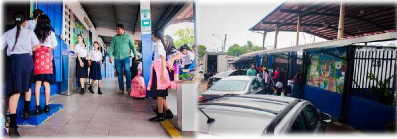
Construcción de marquesina y baldosa de La Escuela Tomás Martín Feuillet. Inversión: B/. 19,941.96
