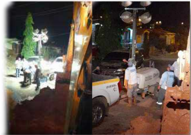
Retroexcavadora L9P02226: IDAAN, apoyo con rotura.
